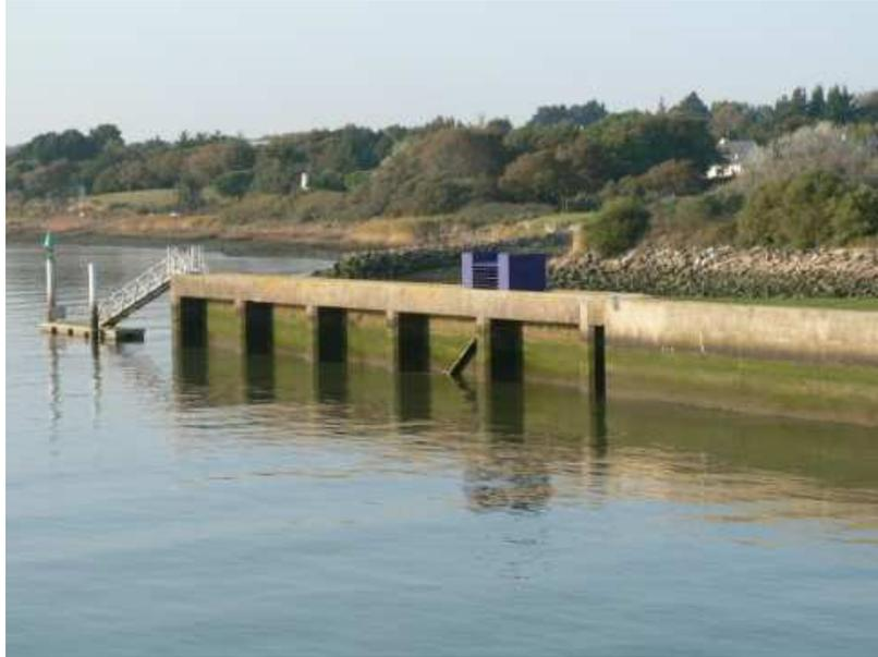
*Passé à anguille construite en rive droite du barrage d'Arzal : la rampe plongeant dans l'estuaire et le local de piégeage (Source : IAV)*
