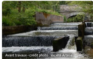
Avant travaux - crédit photo : société Artélia
