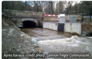
Après travaux - crédit photo : Lannion-Trégor Communauté
