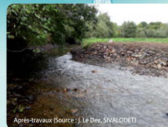
Après-travaux (Source : J. Le Dez, SIVALODET)
