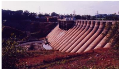
Barrage de Vézin sur la Sélune
