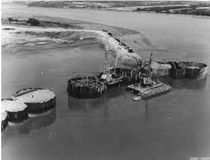
Photo Eaux & Vilaine, construction du barrage d'Arzal
