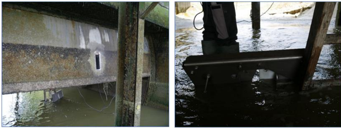
Aménagement de la vantelle sur le clapet à la mer du Canal des Allemands (Source : SBCDOL)
