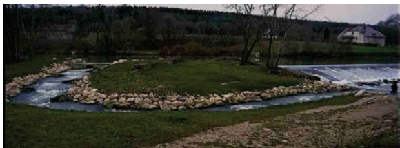
Photographie 19 : Rivière de contournement Châtillon sur Lison (25) – rivière Loue (GHAAPPE)
