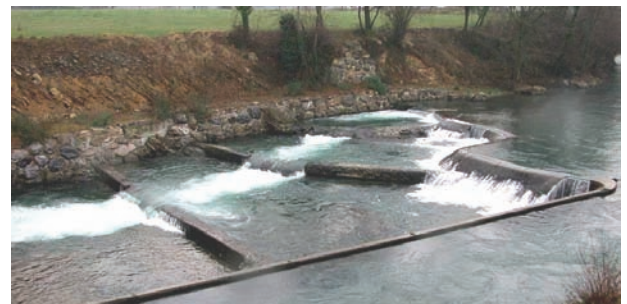
Photographie 13 : Prébarrages Gurmençon (64) - rivière Gave d'Aspe (GHAAPPE)
