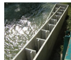
Photographie 6 : Passe à échancrures latérales. Pont de Beauvoisin (73) barrage la Baronnie - rivière Guiers (GEI/SIEE)
