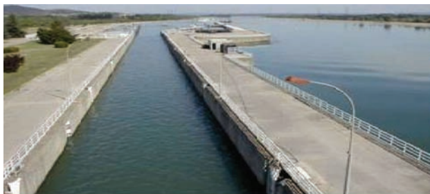
Photographie 23 : Ecluse de navigation de Beaucaire (40) - rivière Rhône (GHAAPPE)
