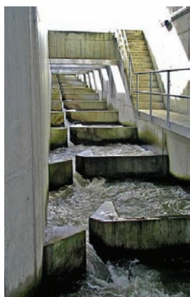
Photographie 5 : Passe à bassins à fentes verticales d'Iffezheim sur le Rhin (GHAAPPE)
