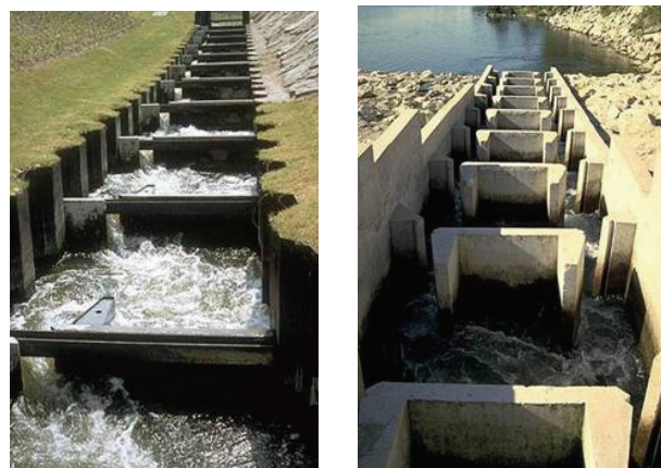
Photographie 8 : Passe à fentes verticales Méricourt (78) - rivière Seine et passe à fentes verticales Bonicolti (30) - rivière Gardon (GHAAPPE)
