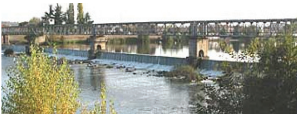
Figure 28 : Vue du barrage de Roanne- Loire
