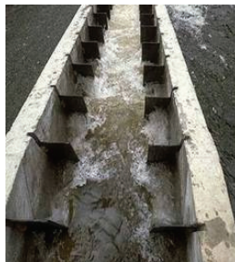
Photographie 15 : Passe à ralentisseurs plans en Normandie (GHAAPPE)
