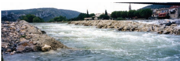
Photographie 9 : Passe à seuils déversants St Martin d'Ardèche (07) - rivière Ardèche (GEI/SIEE)
