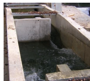
Photographie 7 : Pont de Beauvoisin (73) barrage Cholat - rivière Guiers (GEI/SIEE)
