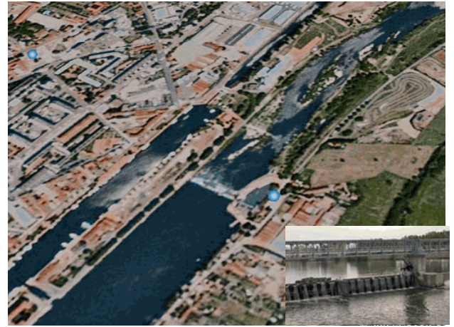
Photographie 3: Barrage de prise d'eau de Roanne (IGN)
