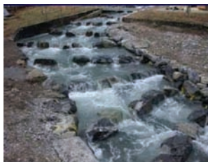
Photographie 18 : Passe naturelle à rangées de rugosités – Allemagne (Gebler)
