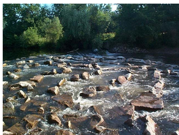
Figure 20 : Rampe en enrochements périodiques à Kolbsheim : vue avant aménagement, vues depuis l'aval en étiage et en crue.
