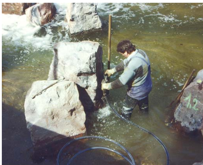
Figure 31 : Mise en place de pieux métalliques pour stabiliser les blocs.
