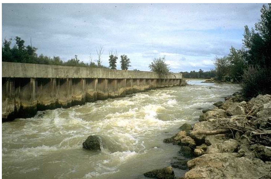
Figure 19 : Rampe en enrochements jointifs au seuil de Toulourette
