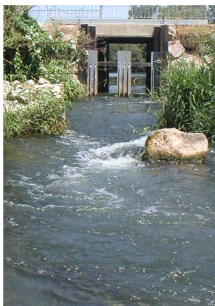
Figure 23 : Rivière de contournement du Bras des Arméniers
