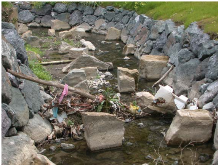
Figure 28 : Exemple d'embâcles au sein de dispositifs.
