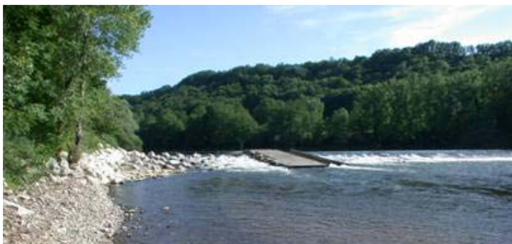
Figure 16 : Rampe en enrochements de Carennac (Dordogne)
