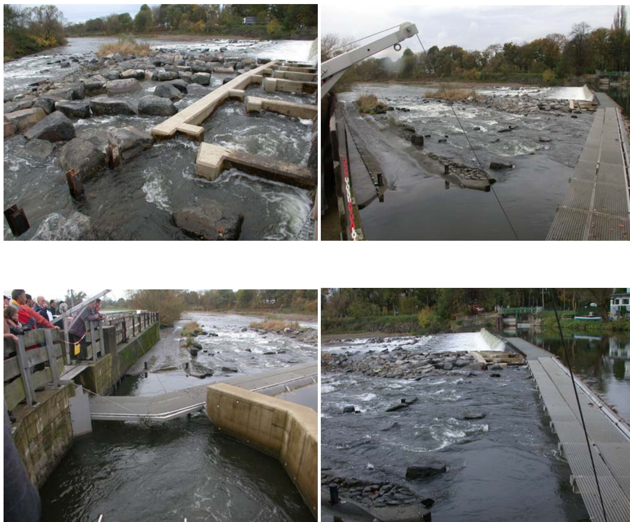
Figure 18 : Rampe en enrochements au seuil de Buisdorf sur la Sieg
