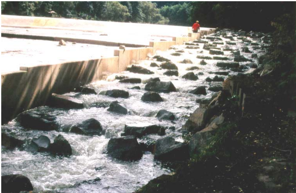
Figure 7 : Ecoulement au travers d'enrochements en rangées périodiques
