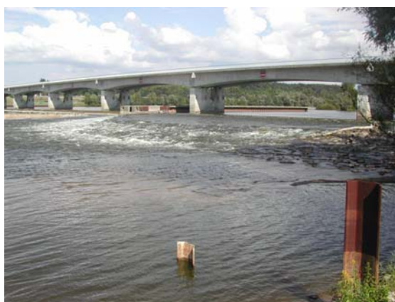
Figure 21 : Prébarrage en enrochements jointifs au seuil de Belleville (Loire)
