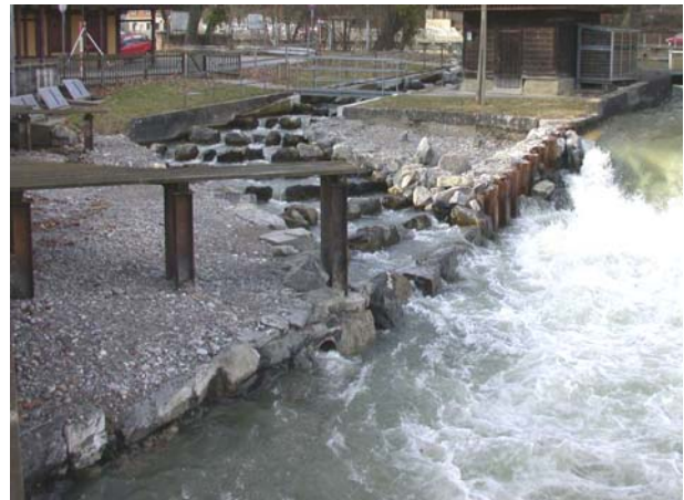
Figure 27 : Rivière de contournement sur l'Aare (Suisse)
