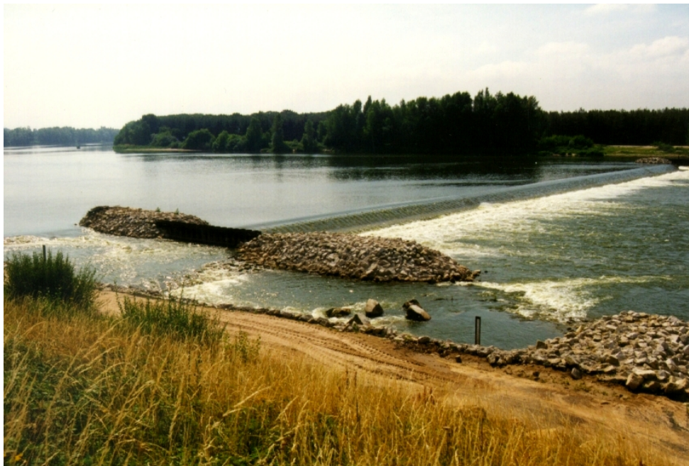
Figure 15 : Seuil de Dampierre sur la Loire équipé sur chaque rive de prébarrages constitués de rampes en enrochements jointifs
