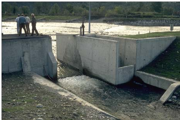
Figure 26 : Rivière de contournement du Lac des Gaves (Gave de Pau) : vue générale, vue de la rivière, vue du clapet amont et de la passe à bassins, vue de l'entrée au niveau de la centrale aval.
