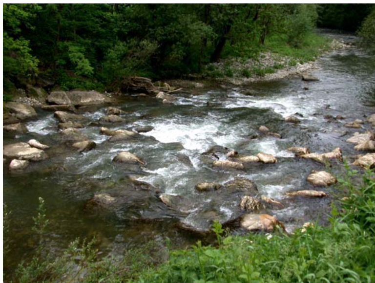
Figure 11 : Ancien seuil de stabilisation sur les Usses
