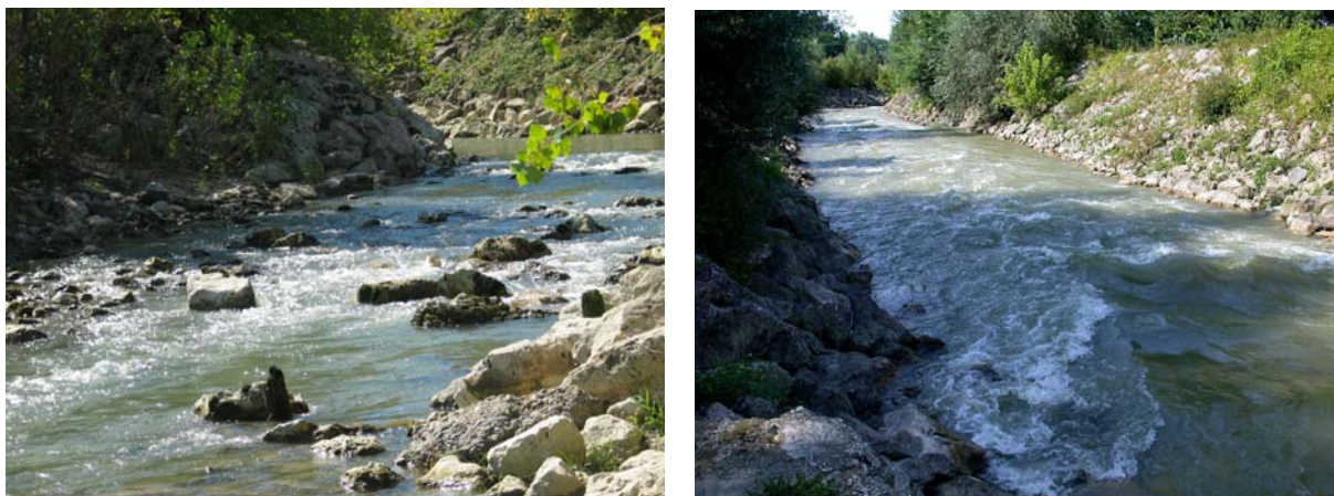
Figure 22 : Rivière de contournement au seuil de Beauregard sur la Garonne en étiage et en hautes eaux
