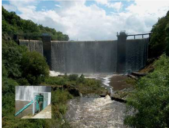
Passe piège à anguilles du barrage de Pont Rolland sur le Gouessant (FDPPMA22)
