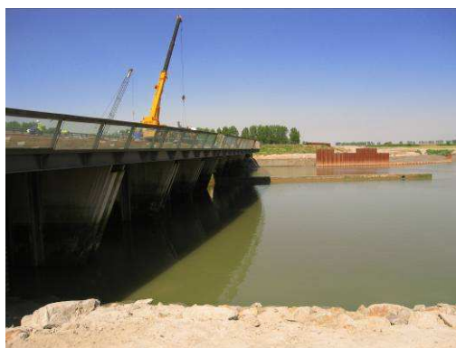
Nouveau barrage de la Caserne sur le Couesnon (BGM, 2009)
