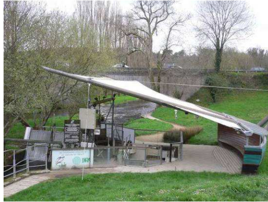
Station de contrôle du moulin des Princes (ou moulin à Tan) sur le Scorff
