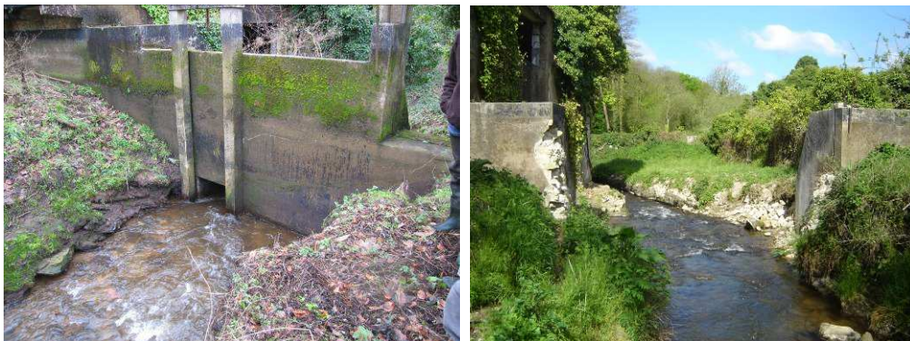
Barrage de Kervéneur avant démolition (BGM, 2009) et après démolition (Syndicat de l'Horn, 2010)
