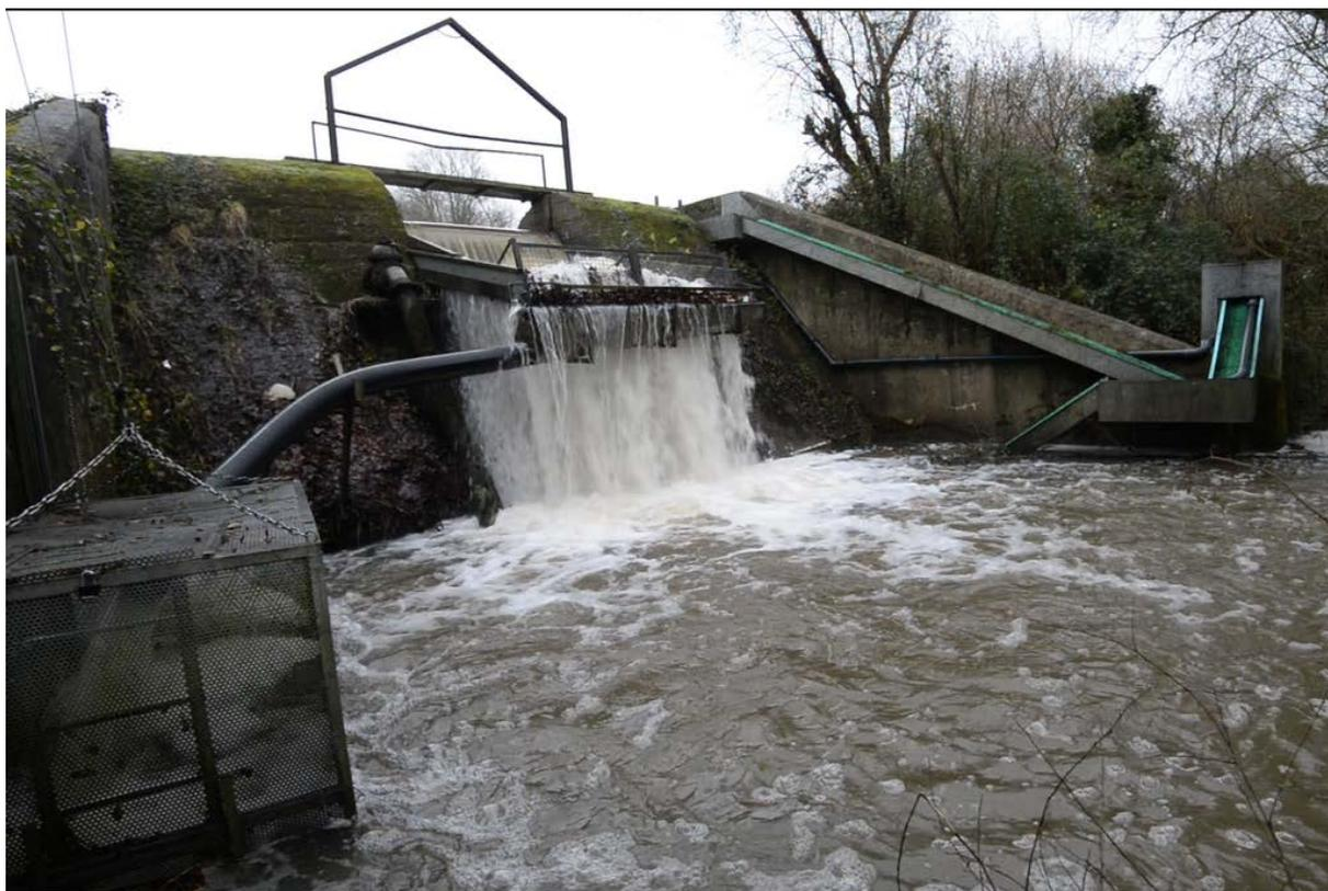
Figure 6 : Barrage de Pont es Omnes (vue aval en surverse) et piège de dévalaison à gauche et de montaison à droite (V.Danet)
