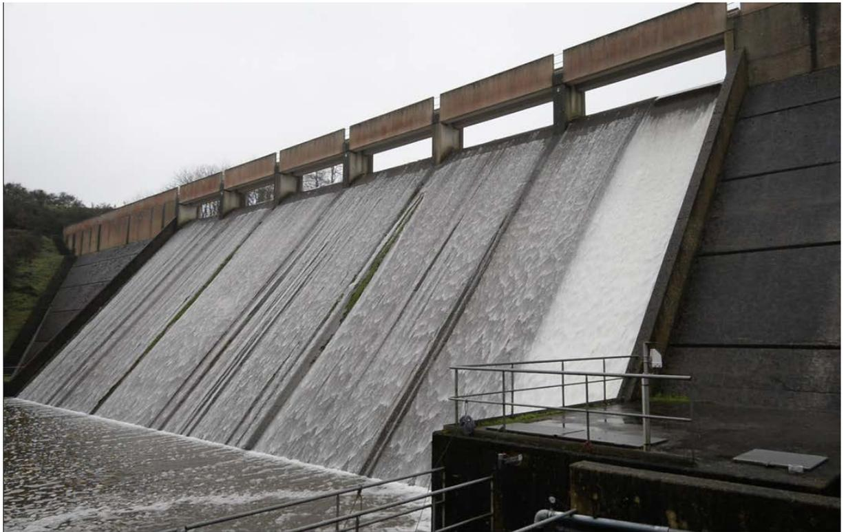
**Figure 3 : Barrage de Bois Joli en phase de surverse (vue aval) (V.Danet)**
