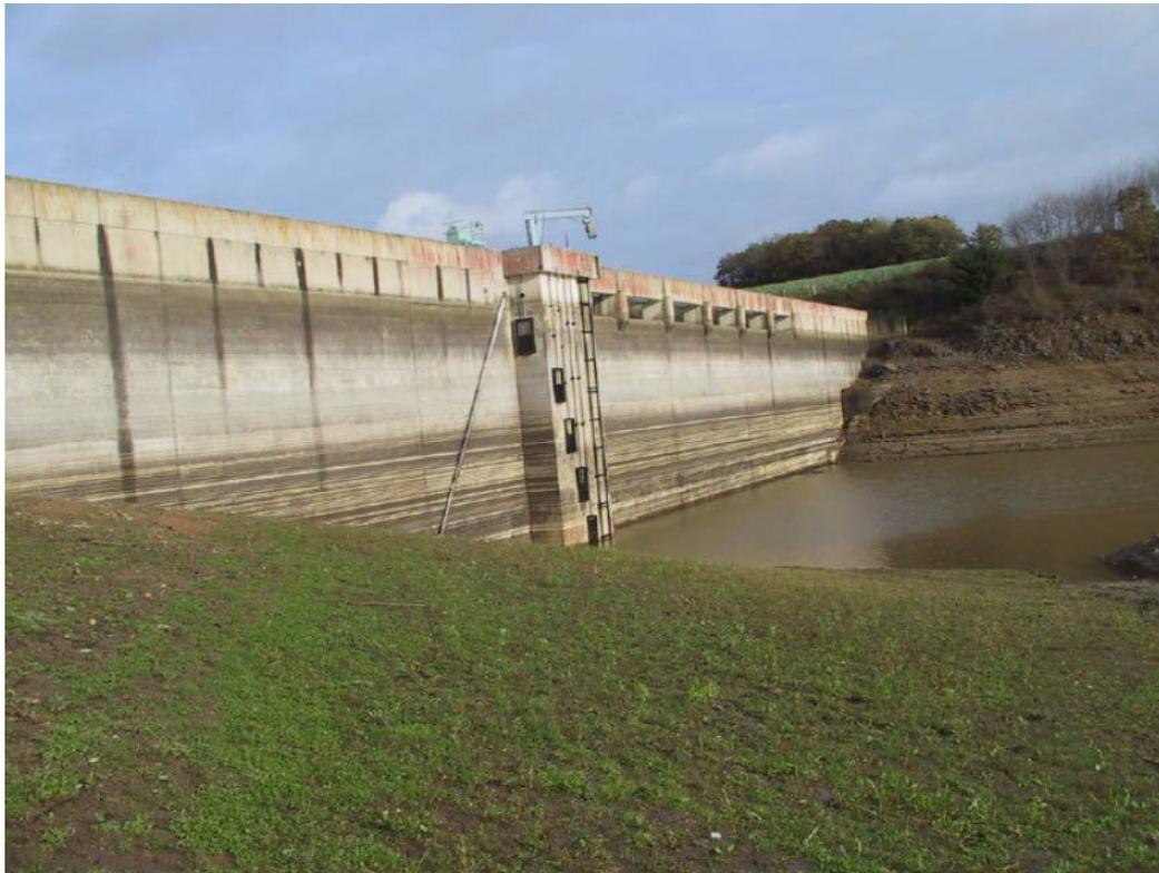
Figure 4 : Tour de prélèvement d'eau potable avec les 5 prises d'eau (vue amont du barrage du Bois Joli)
