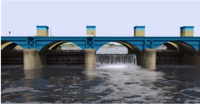
FIGURE 2 – Vue montrant un écoulement sur le volet 4 à partir de l'aval du barrage.
