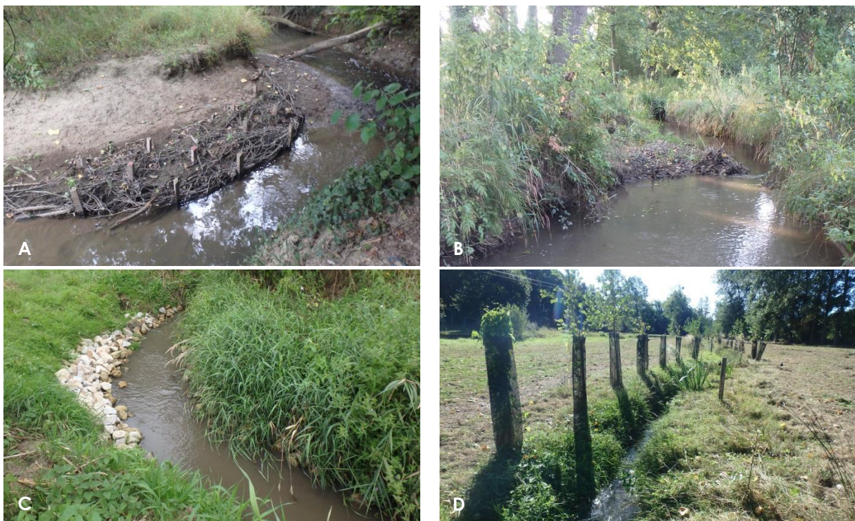
Figure 2 : A et B, travaux de resserrement du lit du Frémur réalisés sur le secteur de Pleslin. C, travaux de reméandrage et de recharge granulométrique réalisés sur le secteur de Trélat. D, remise en talweg du Frémur sur le secteur Trélat Amont
