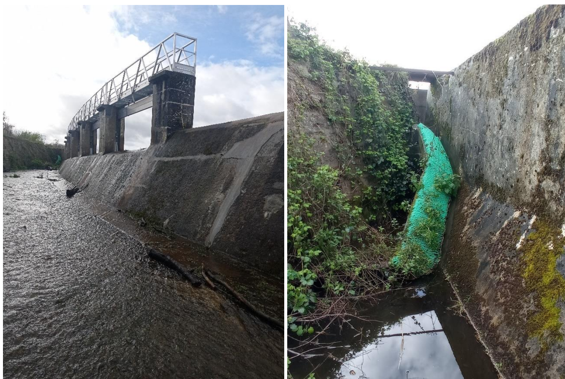
Figure 11 : A gauche, vue aval du barrage de Pont Avet et à droite sa passe à anguilles (FISH-PASS)
