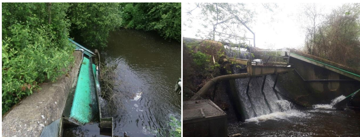
Figure 13 : Passe et piège sur le barrage de Pont-es-Omnès (FISH-PASS)
