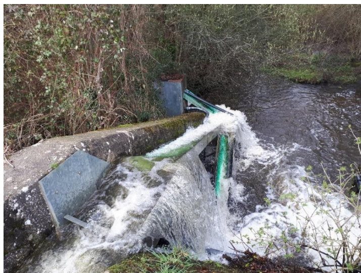
Figure 70: Passe à anguilles de Pont es Omnes non fonctionnelle compte-tenu des niveaux d'eau (Fish-Pass)
