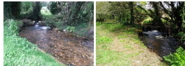
Avant et après travaux © F. Carré, Lorient agglomération
