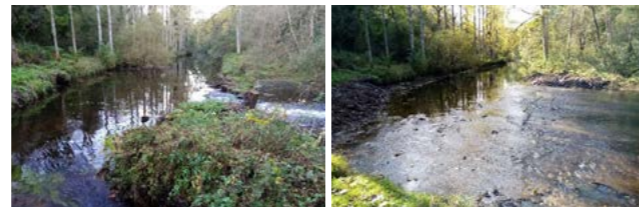
Avant et après travaux © : M. Beldame, GPA
