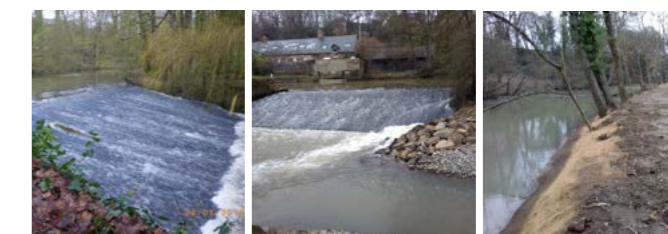
Avant et après travaux © : O. Agator, Syndicat du Semnon
