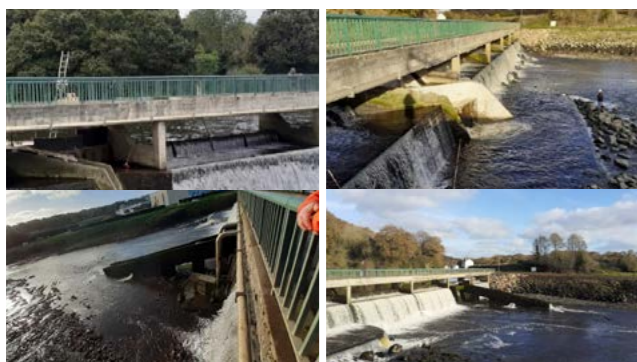
Avant et après travaux © : S. Mer, CD22
