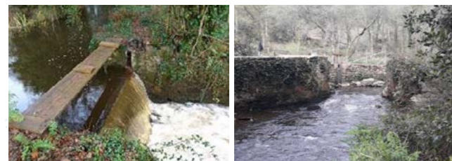
Avant et après travaux © DCI environnement / V. Guével, DDTM 56
