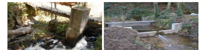
Avant et après travaux © B. Guesdon, CCA
