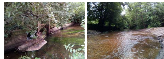
Avant et après travaux © Morlaix Communauté
